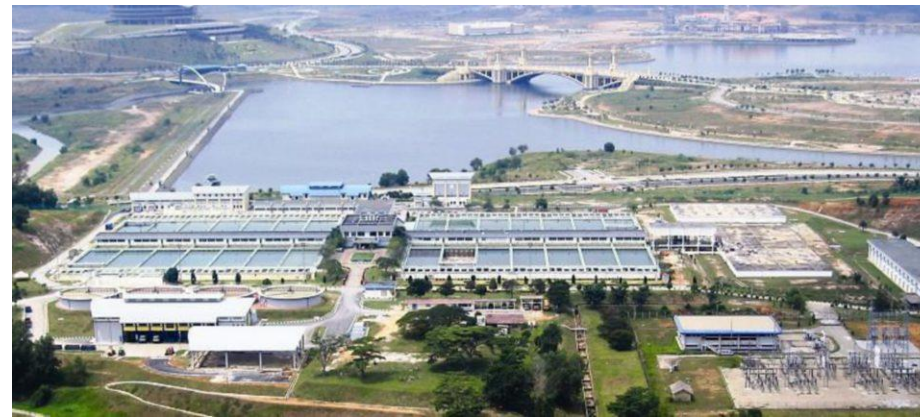
LRA Semenyih – Maintenance Work
